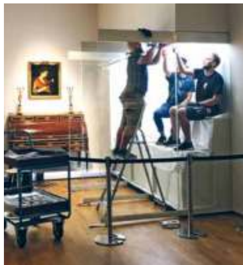
Fachleute tauschen im Ausstellungsbereich Klassizismus die alte energieintensive Beleuchtung gegen LED-Panels aus.
